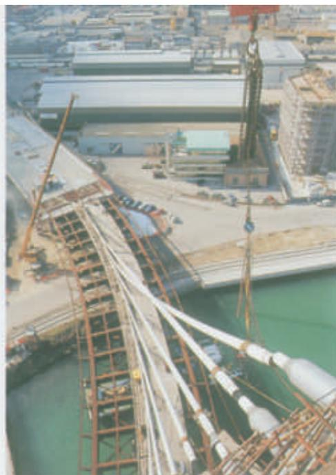
Sopra, posa in opera e tensionamento degli stralli. Nella pagina a fianco, diverse fasi di montaggio e tamponamento esterno dell'impalcato.
